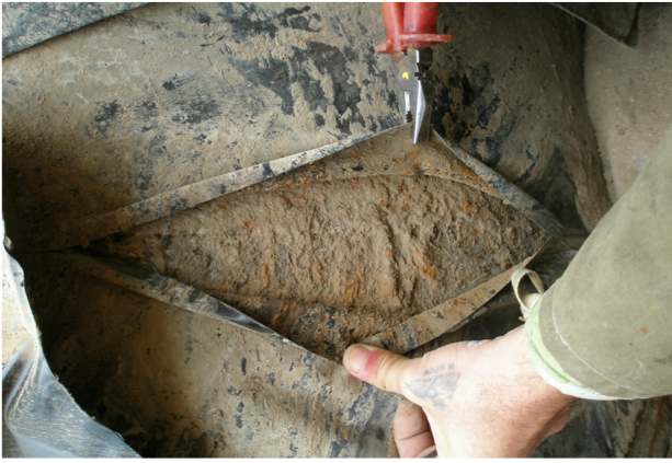
Рисунок 9 – Приклади відшарування ізоляційного покриття магістрального трубопроводу
