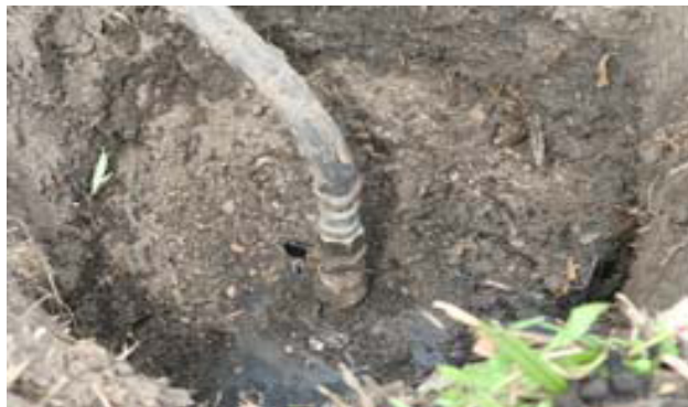
Рисунок 10 – Характер врізань у магістральний нафтопровід, які супроводжуються пошкодженням ізоляційного покриття основного трубопроводу
