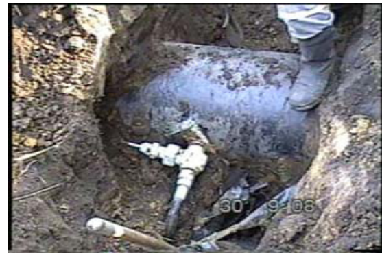
Рисунок 10 – Характер врізань у магістральний нафтопровід, які супроводжуються пошкодженням ізоляційного покриття основного трубопроводу
