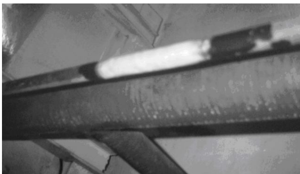
Рисунок 10 – Трубопровід конденсату, утвореного з пари під тиском P=1,0 МПа, з намотаним бандажем (12 листопада 2007р.)
