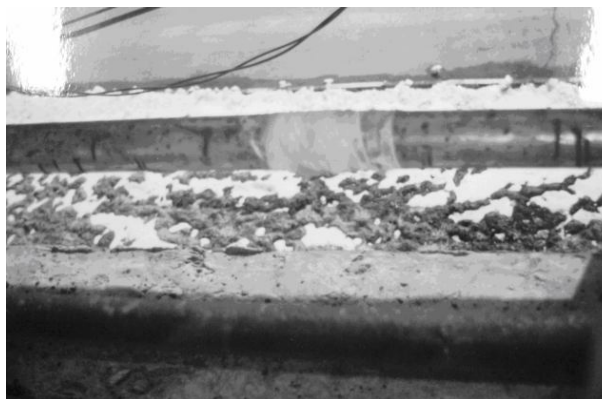
Рисунок 7 – Трубопровід технологічного повітря з намотаним бандажем 11 листопада 2003 р.
