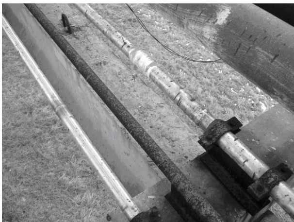
Рисунок 9 – Трубопровід технологічного повітря з намотаним бандажем (12 листопада 2007 р.)
