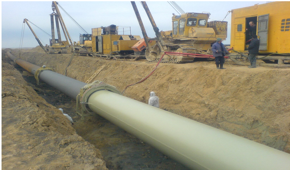
Рисунок 3 – Комплекс для капітального ремонту трубопроводів КРТ
