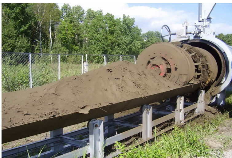
Рисунок 9 – Результати очищення ділянок МГ
