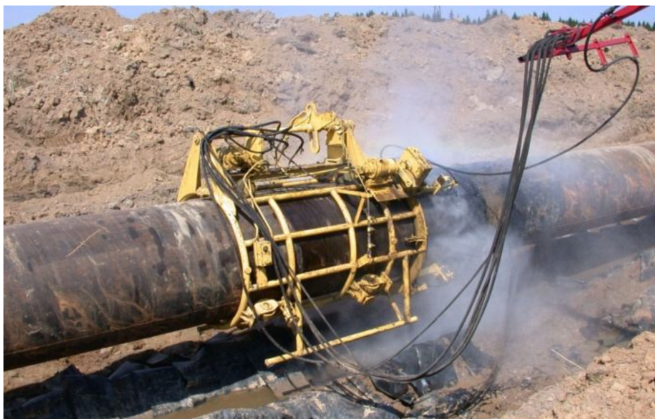
Рисунок 4 – Універсальна самохідна машина. Видалення старої ізоляції [2]
