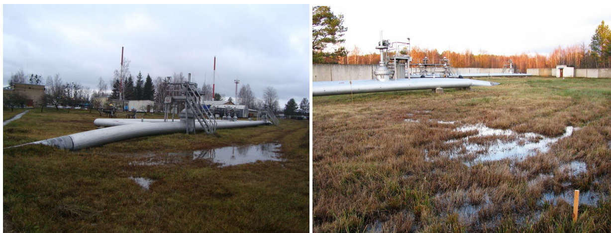
Рисунок 6 – Вигляд затопленої водою досліджуваної ділянки НПС з наявними підземними нафтопроводами на ній
