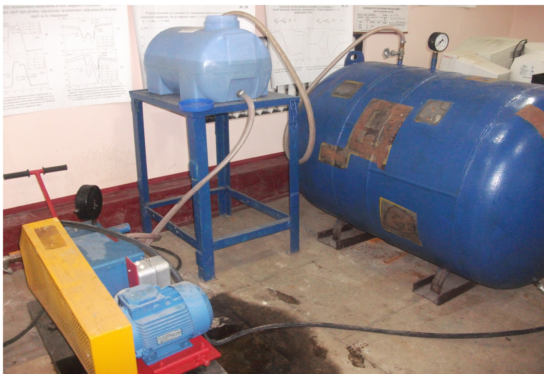
Рисунок 4 – Насосна станція дослідницького стенду
