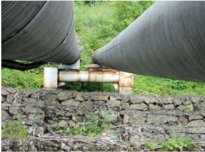
Рис. 3. Загальний вигляд першої (за течінням нафти) опори після ремонту
