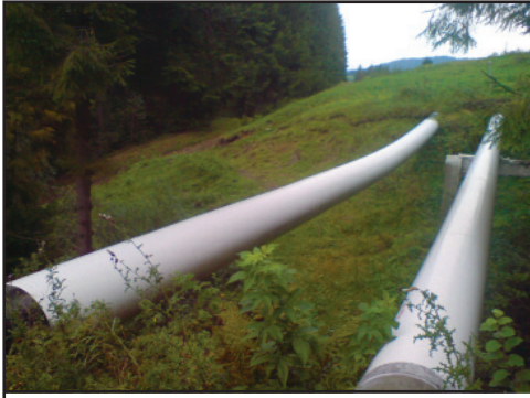
Рис. 2. Надземний перехід нафтопроводу «Дружба» у Карпатах
