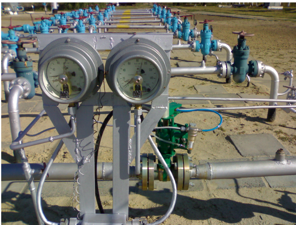
Рисунок 3 – Зразок автоматичних комплексів керування свердловинами на УКПГ № 3 Шебелинського ГКР
