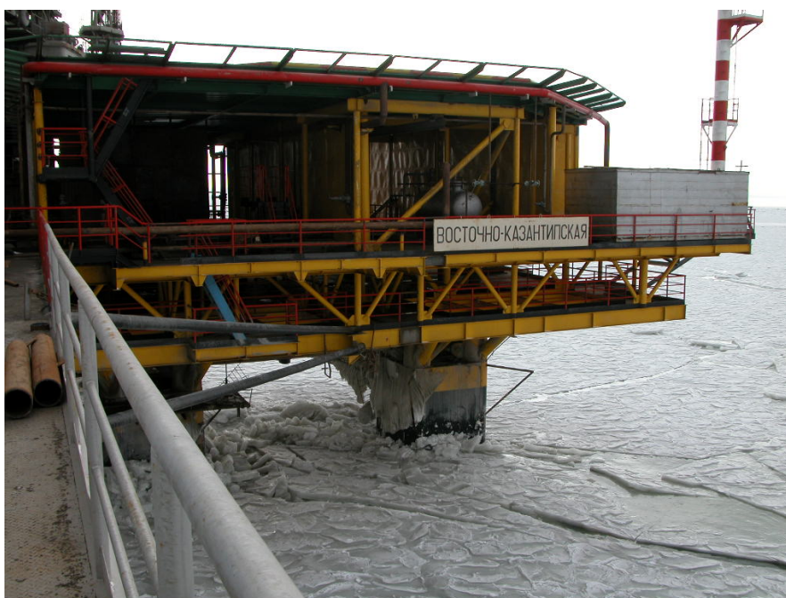
Рисунок 2 – Льодове навантаження на опори
