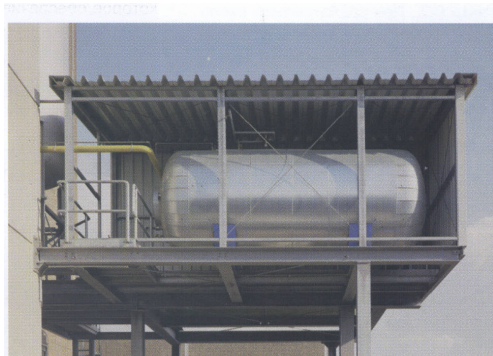
Рисунок 5 — Установка пожежогасіння (CO 2 ) низького тиску з резервуаром, приймально-контрольним приладом, пневматичним пристроєм затримки часу і клапанами напрямків
