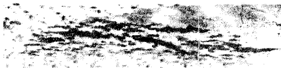
Рисунок 1.3 – Виявлений на трубі діаметром 1420 мм ділянки магістрального газопроводу “Уренгой – Центр 2” за результатами дефектоскопії у 2004 р. поздовжній груповий дефект стрес-корозійного характеру [155, 166]
