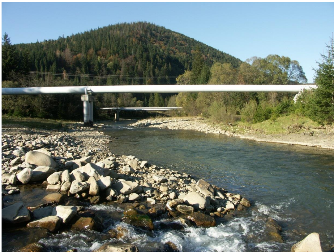
Рисунок 1.8 – Трубопроводи, що проходять в одному технічному коридорі та перетинають природні перешкоди
