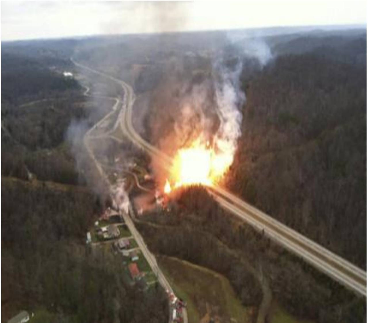
Рисунок 6.1. – Руйнування трубопроводів у спільному технічному коридорі
