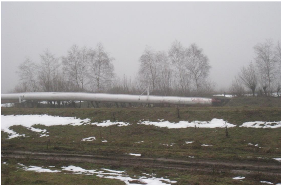
Рисунок 5.10 – Ділянка газопроводу із переходу підземного прокладання у надземне. (газопровід Союз)
