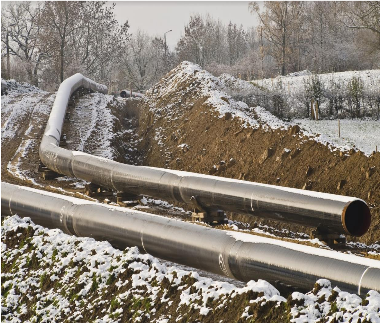
Рисунок 6.4 – Взаємне прокладання двох ниток трубопроводів
