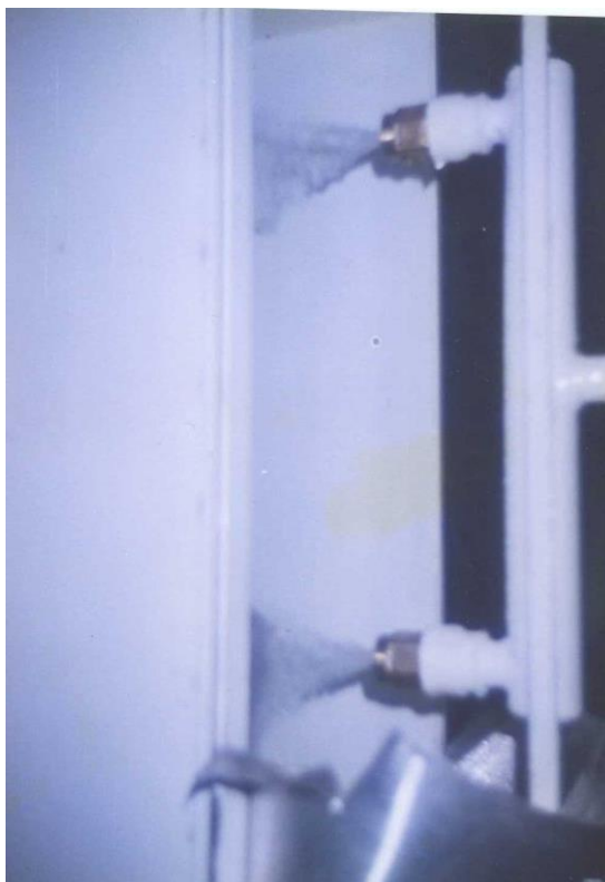
Рисунок Д.1 Робота форсунок ежекційного апарату при обробці повітря для вирощування грибів
