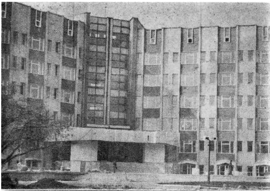
Новозбудований корпус ФАЕ
