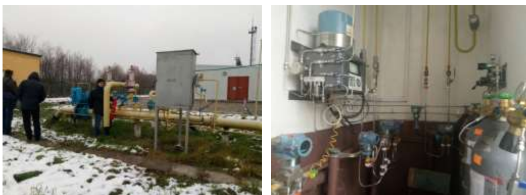
Рис. 12. Відбір проби на ГРС Угринів та використання потокового хроматографа Danaluxer 370 ХА.
