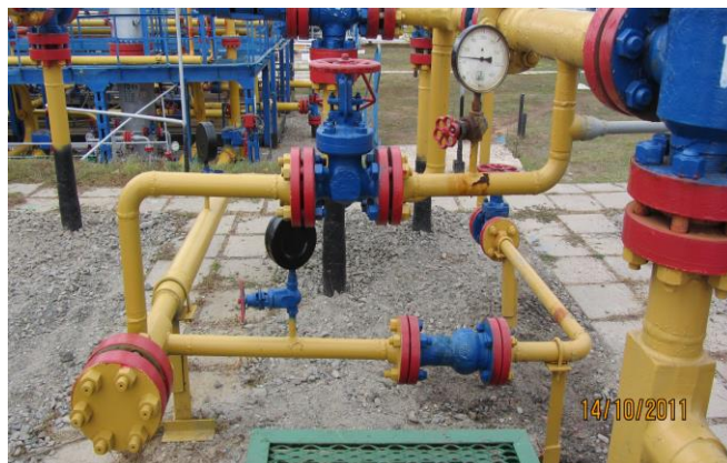
Рисунок 1.11 – Схема обв'язки змонтованого ежектора
