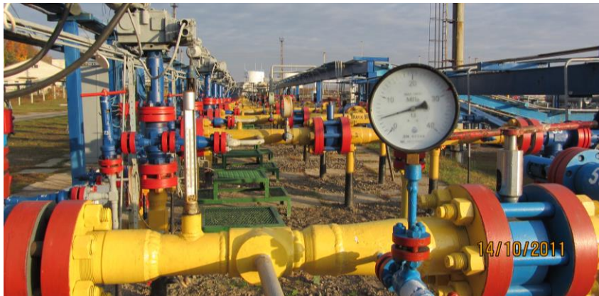
Рисунок 1.10 – Контролювання експлуатаційних параметрів під час створювання швидкісного газорідного потоку у шлейфі свердловин
