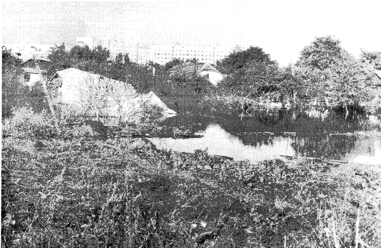
Рисунок 1.4. Наслідки раптового просідання земної поверхні над відпрацьованими виробками шахти «Калуш» по вул. Вітовського (колишня Пархоменка) 07.06.1987 року (зі звіту НДІ «Галургія»).
