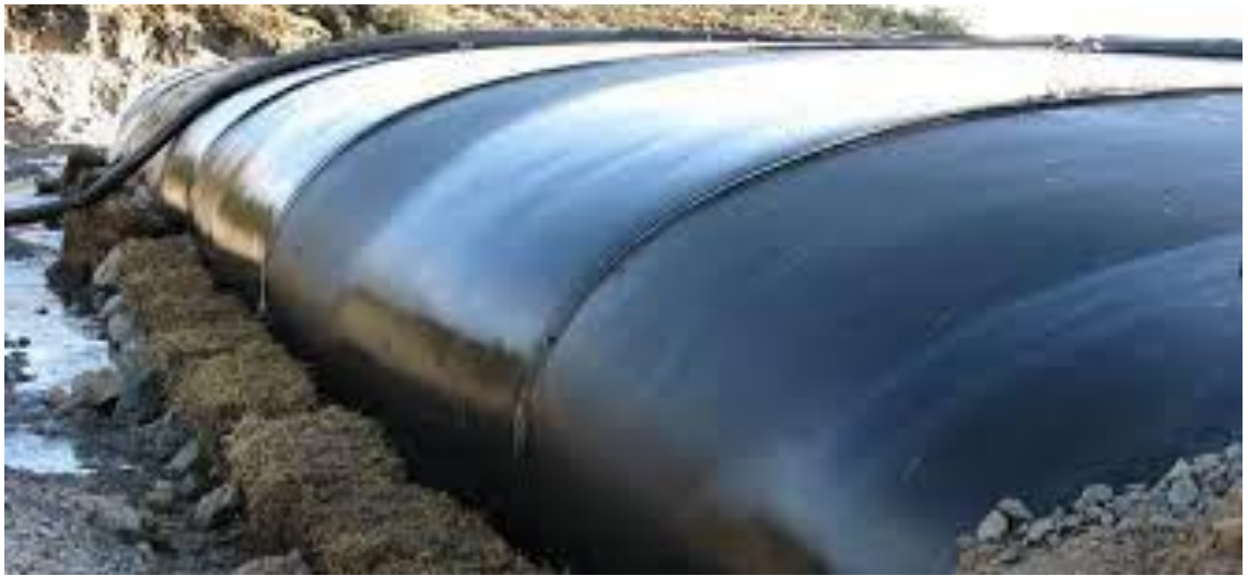
Рис.1.7 – Захист від повені геотубами
