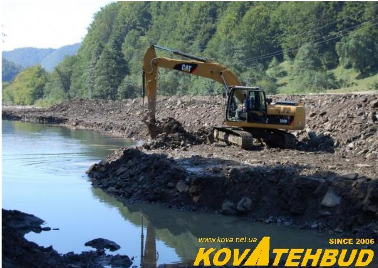
Рис. 1.10 – Роботи по берегоукріпленню річки Дністер
